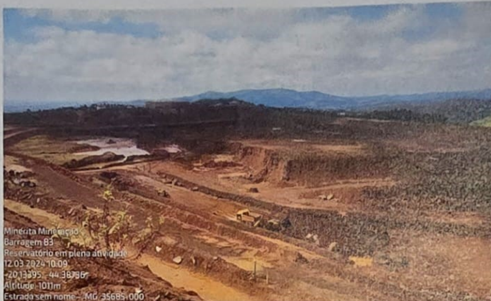
Escavação realizada por conjuntos escavadeiras e caminhões basculantes.
